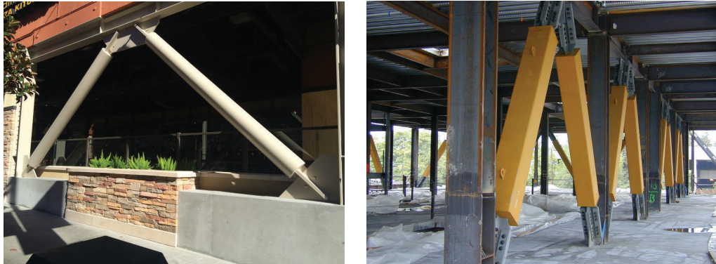
Şekil 1.7 : Burkulması önlenmiş çaprazlı çerçeve uygulama örnekleri ( [4]'den alınmıştır).
